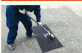
路面貼付後、丁寧に足踏みするか、手押しローラ、タンバ、木槌などでマット表面に満遍なく圧力を加え路面と密着させる。
