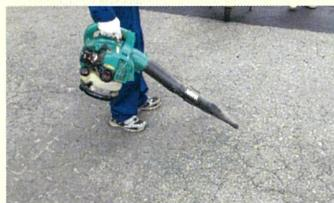
補修箇所を送風機、等などで清掃し、埃や砂利を取り除く。路面がぬれている場合は乾燥させてから作業を行う。
