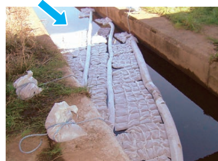
土のうでも支点になります。
