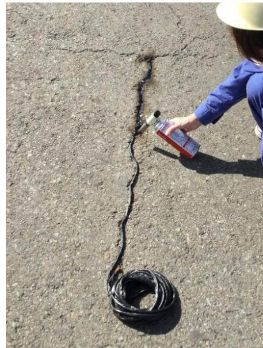
線状クラック補修状況
